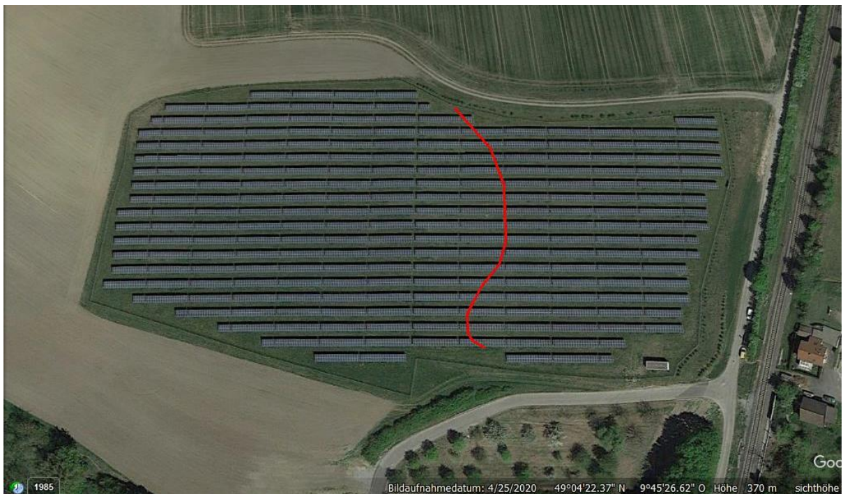
Bild 2: Die PV-Anlage „Hundsäcker“
